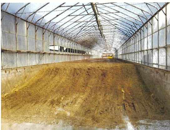
写真9 ロータリー式堆肥化施設の搬入部
