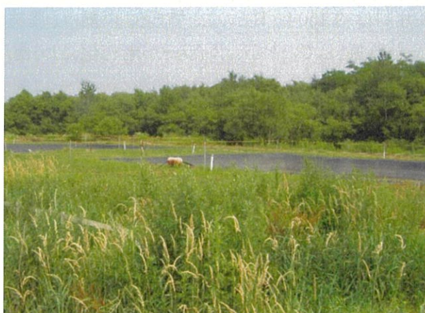
写真2 シートラグーンの汚水貯留槽(右)
