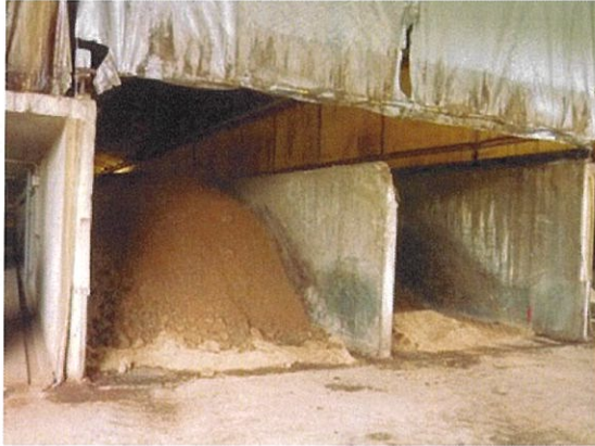
写真1 発酵槽(投入側)
