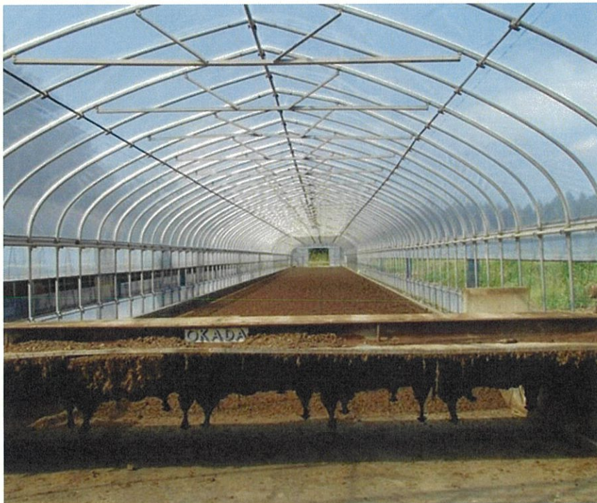
写真5 開放・直線型発酵装置(乾燥ふん搬出側)
