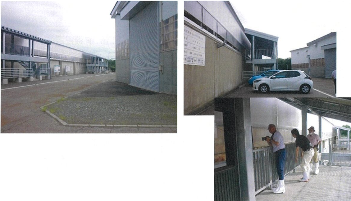
写真 8 堆肥化施設外観(見学者用デッキが設置)
