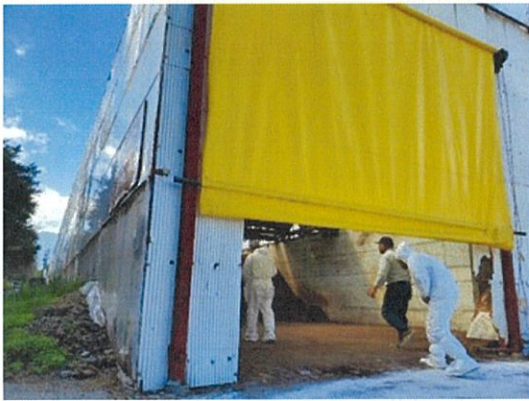
写真4 悪臭拡散防止のため閉鎖される堆肥化施設 (開放時)
