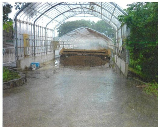
写真10 太陽熱を利用したビニルハウス 堆肥化乾燥施設の例
