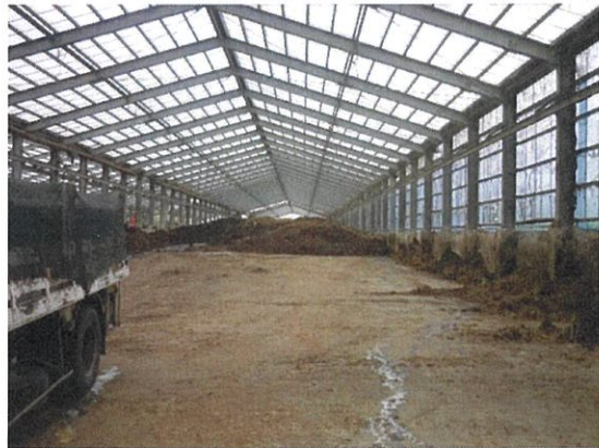
写真3 1棟目の原料投入レーン
