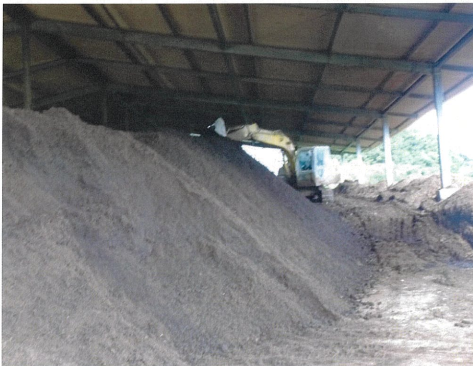
写真9 バックホーを使って積み上げ、切り返し作業を行っている
