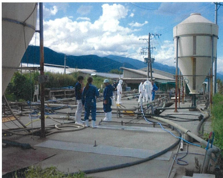
写真7 家畜用浄化処理施設の上部の様子
