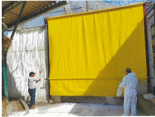
写真5 悪臭拡散防止のため閉鎖される堆肥化施設 (閉鎖時)
