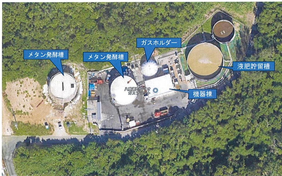
写真7 バイオガスプラントの全景(Google 地図より作成)
